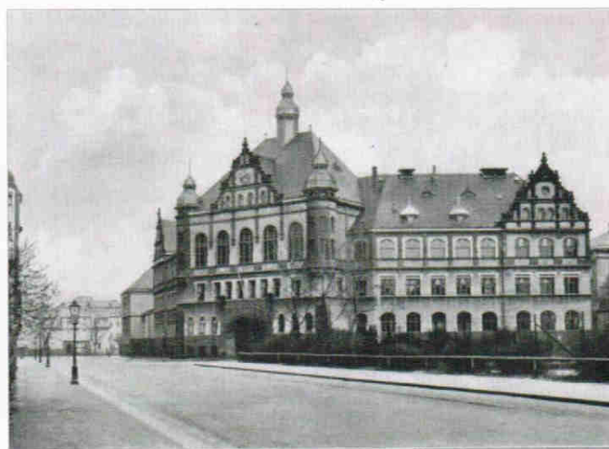
Das Schulgebäude seit 1904
